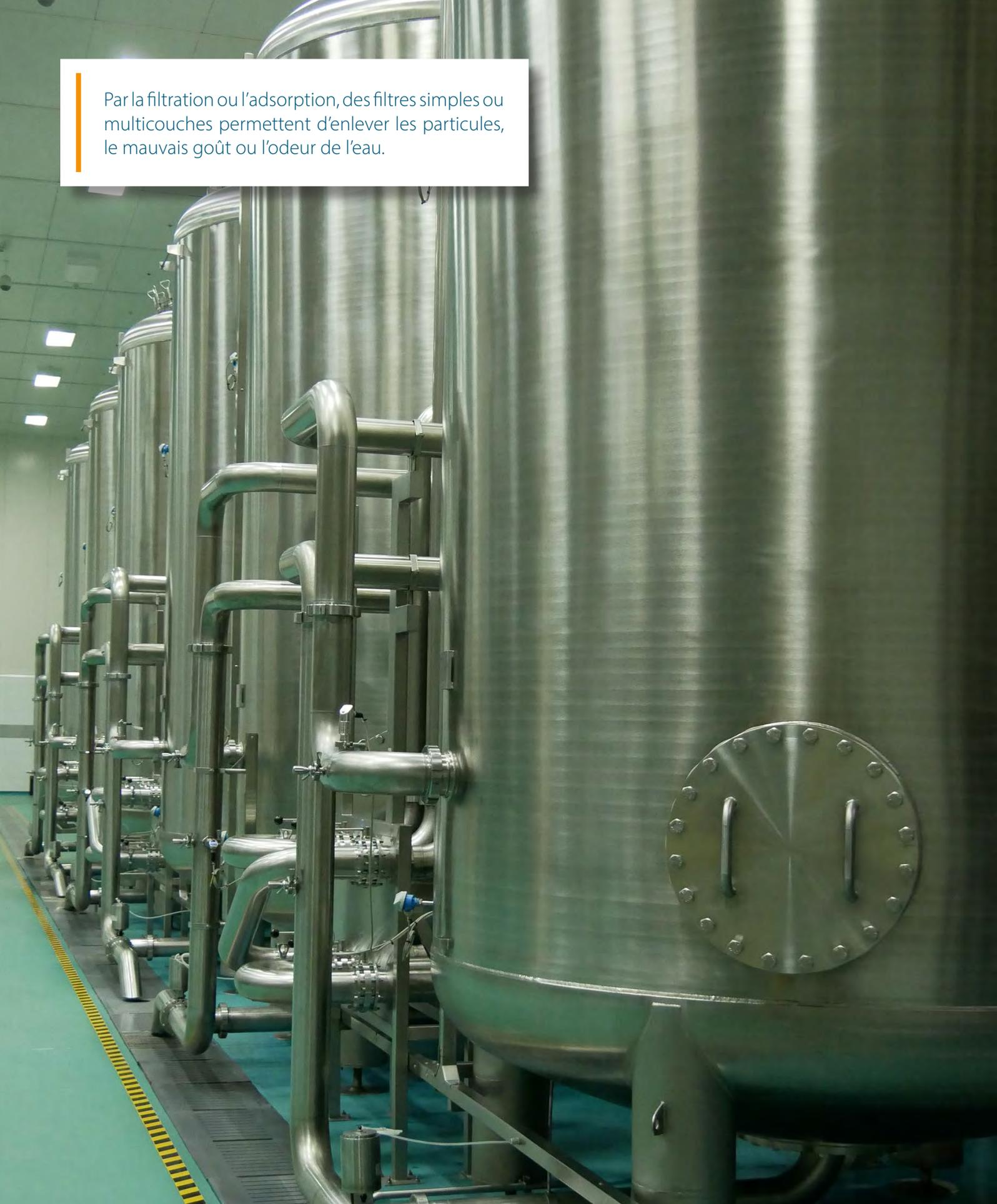
Par la filtration ou l'adsorption, des filtres simples ou multicouches permettent d'enlever les particules, le mauvais goût ou l'odeur de l'eau.
